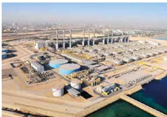
extensíveis a 100.000. O início das obras está previsto para 2020 para terminarem em 2022. Para memória, o projeto possui dois componentes: a construção da central propriamente dita (incluindo a tomada de água, o emissário de descarga no mar, a estação de bombagem e a alimentação elétrica) e a renovação de quase 460 km de redes de distribuição da capital. O nosso escritório de consultores de engenharia dedicar-se-á, nomeadamente, ao controlo e supervisão da construção.
