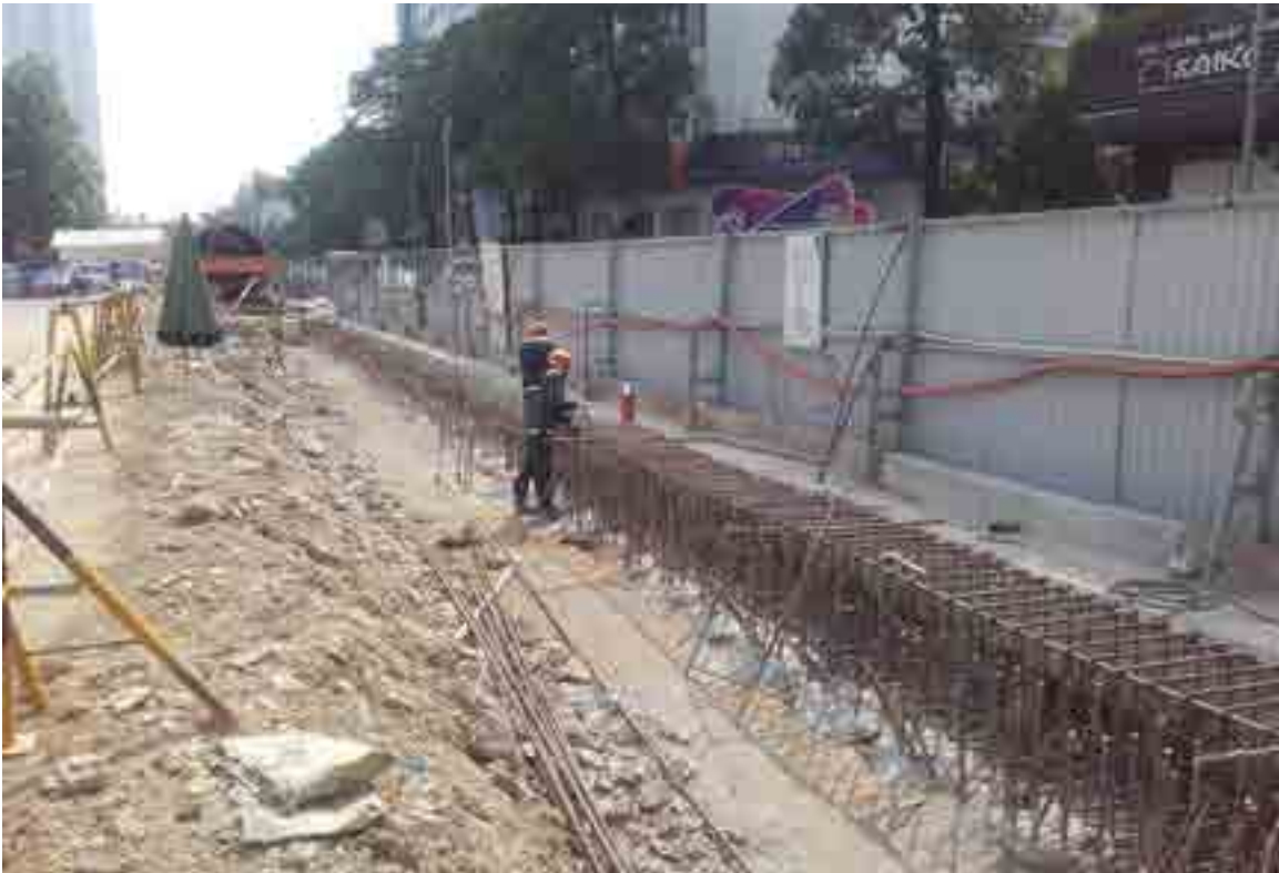
Construction de la ligne de métro pilote n°3 – Hanoi
