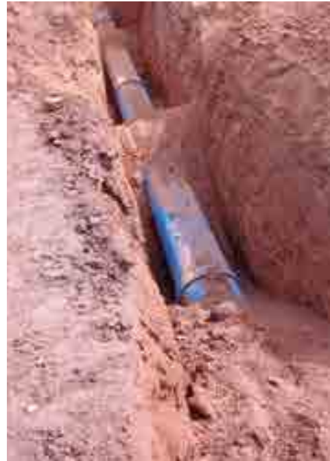
Pose de canalisations en fonte ductile
