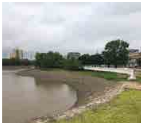
Réhabilitation du système de drainage des eaux pluviales de la ville de Beira
