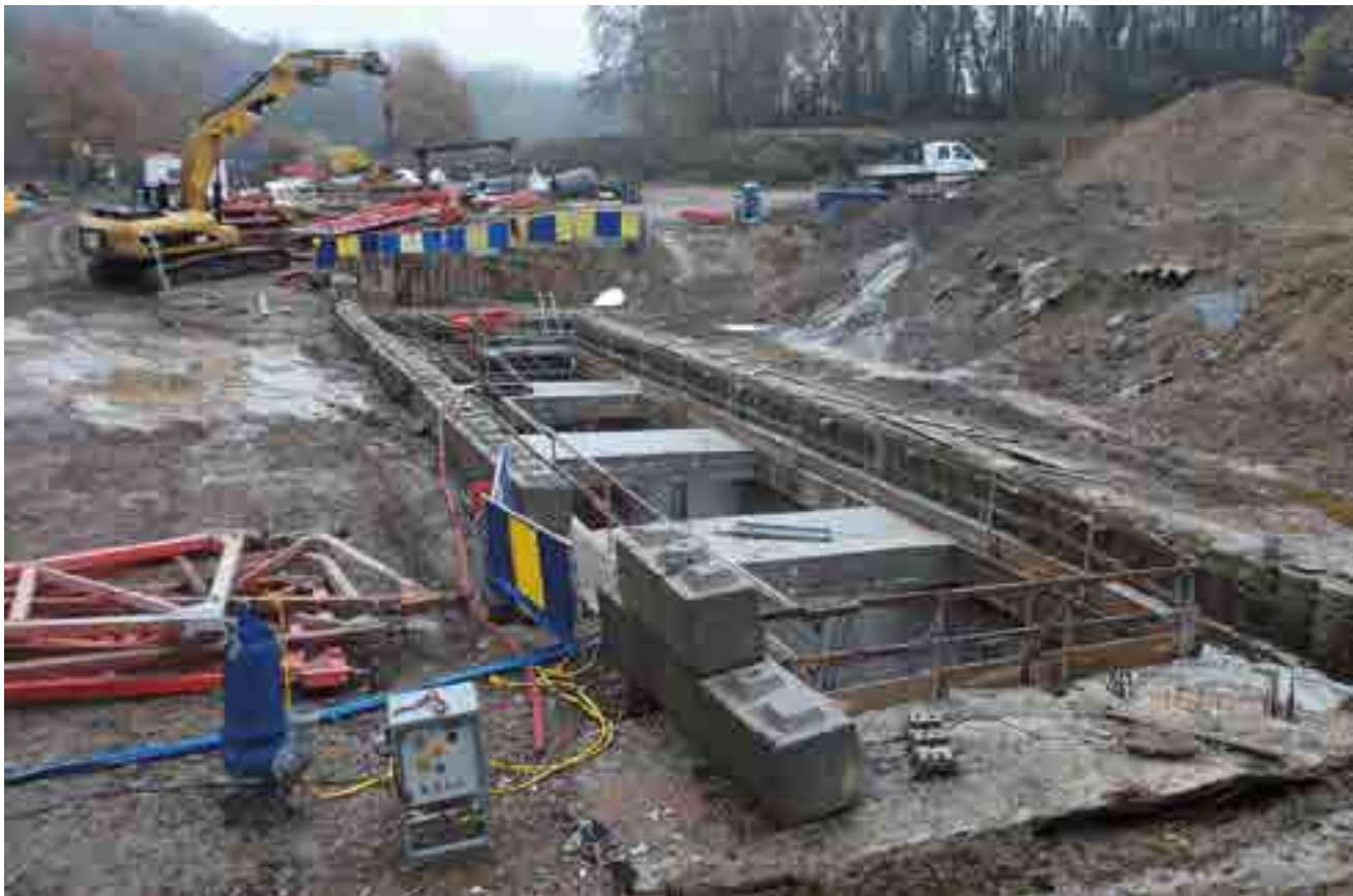
Nouveau collecteur d'égouts - Vallée du Verrewinkelbeek (Bruxelles)
