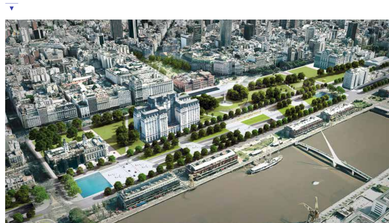
Estrada Paseo del Bajo em Buenos Aires / Argentina
