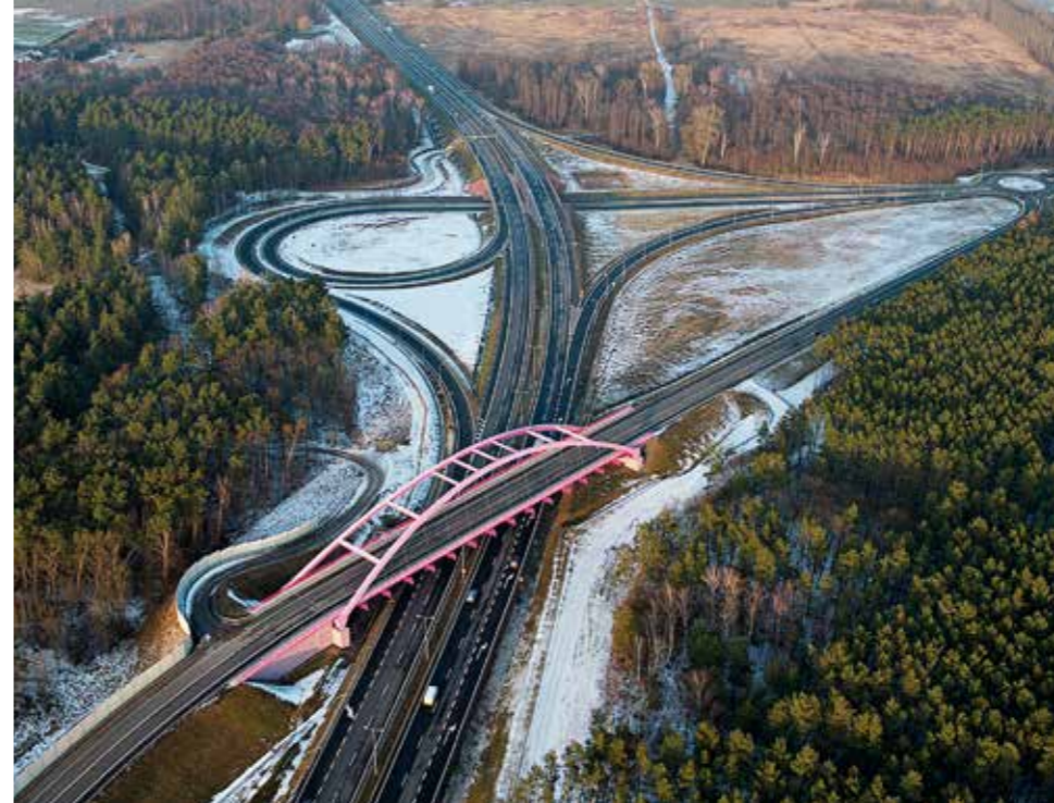
Construction de la voie de droite du boulevard périphérique Ouest de Międzyrzecz / Pologne
